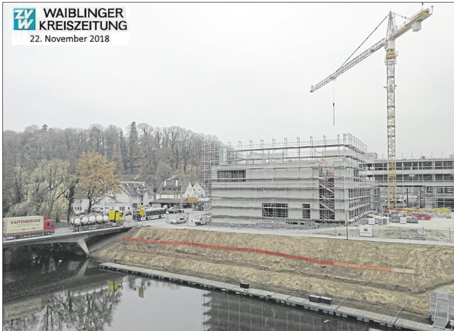
Baustelle für Teil eins der Neuen Mitte mit Stadthalle und Rathaus am Neckarremser Hechtkopf.
