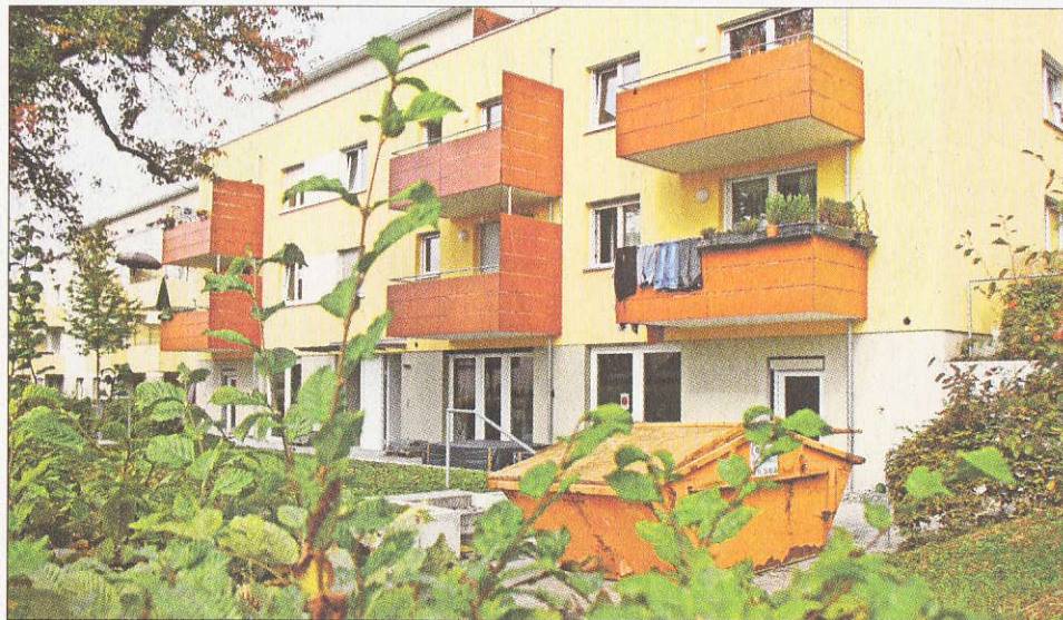
Jahrelang hoffte man, einen kleinen Supermarkt im Neubaugebiet anzusiedeln. Vergeblich. Nun baut die SWSG die Fläche zu zwei Wohnungen um.
