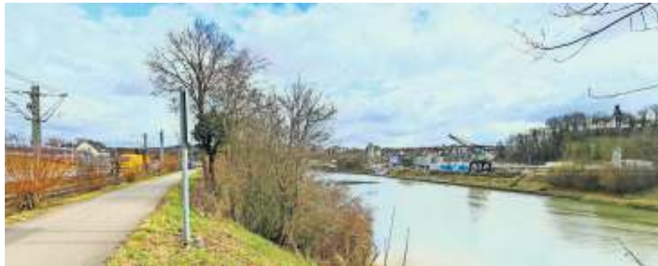
Einige Hundert Meter flussaufwärts der bisherigen Neckarbrücke soll in den kommenden Jahren die Westrandbrücke gebaut werden.
