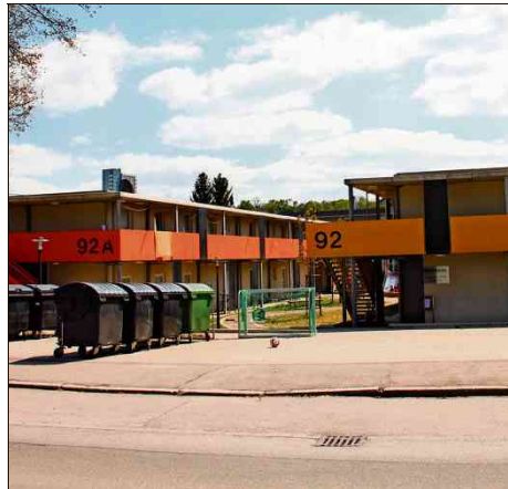
Die Unterkünfte sollen in den kommenden Tagen abgerissen werden. Foto: Georg Friedel
