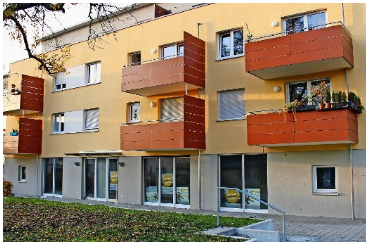
Aus den Versuchen, am Sauerkirchenweg einen Supermarkt zu etablieren, ist nichts geworden. Noch stehen die 140 Quadratmeter der SWSG leer. Foto: Torsten Ströbele
